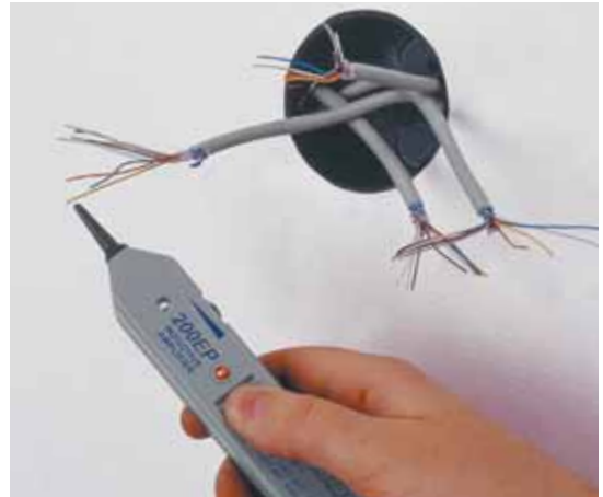
Sadece vericiyi bağladığınızda, kablolar çabucak tespit edilebilir.
